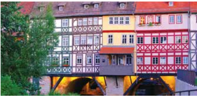
Puente Krämerbrücke, Erfurt / Alemania
